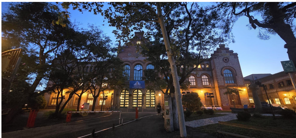
Fotografía 1. Fachada del edificio TR-1.
